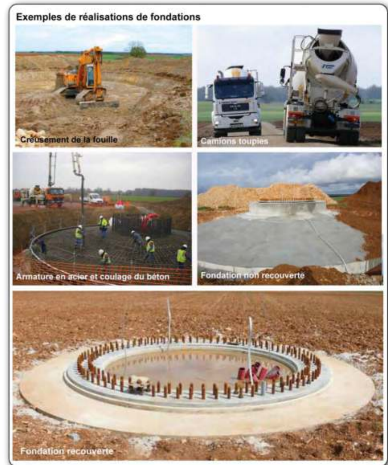
Photographie 55 : Etapes de réalisation d'une fondation d'éolienne
