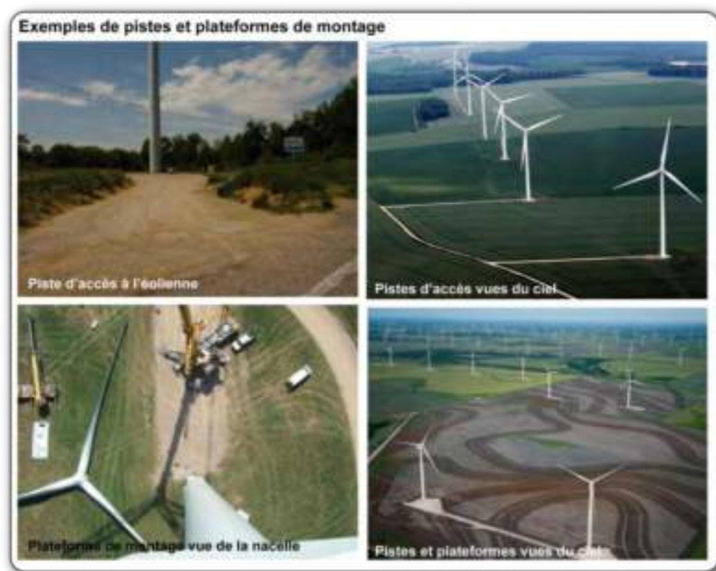
Photographie 47 : Exemples de plateformes de montage et de pistes
