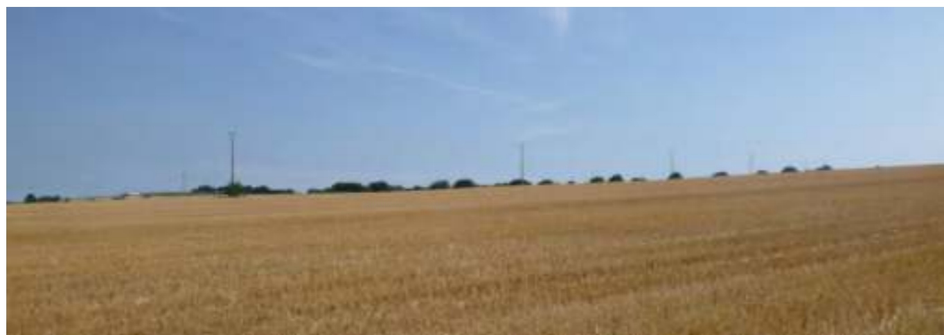
Photographie 32 : Ligne HTA aérienne passant au-dessus du secteur nord de la ZIP (Source : ENCIS Environnement)
