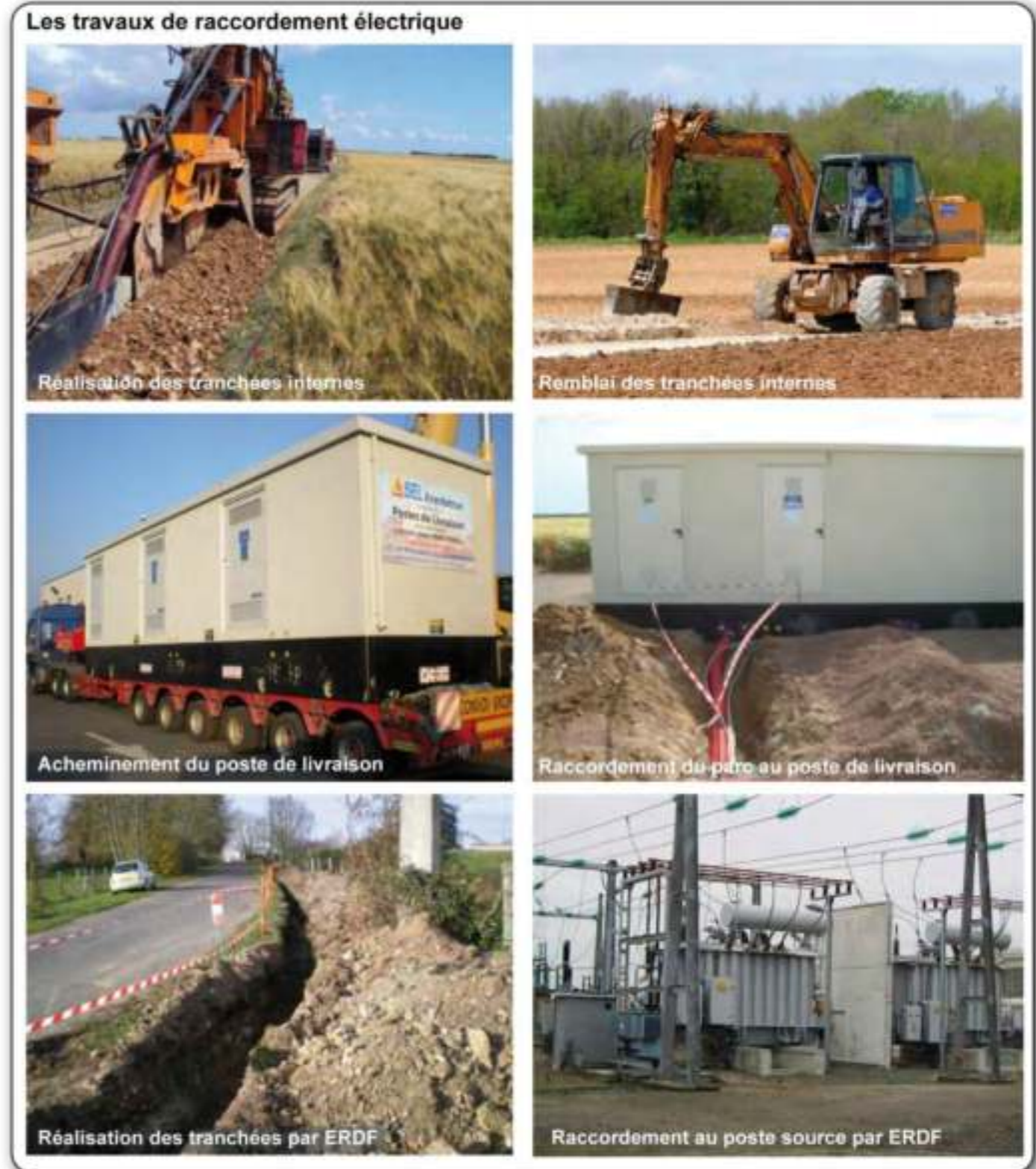
Photographie 56 : Travaux de raccordement électrique
