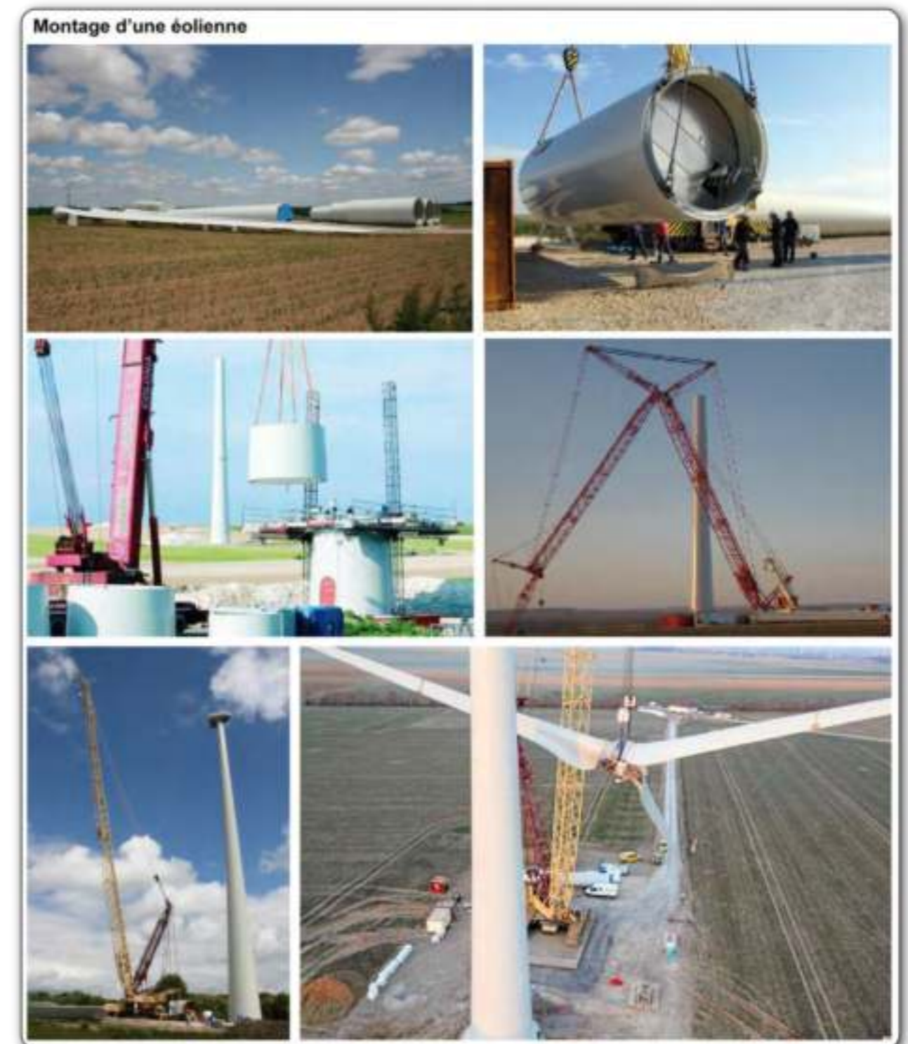
Photographie 57 : Phases d'assemblage d'une éolienne
