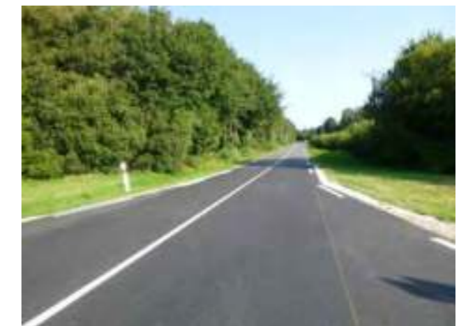
Photographie 21 : D767 au droit de Saint-Mayeux (Source : ENCIS Environnement)
