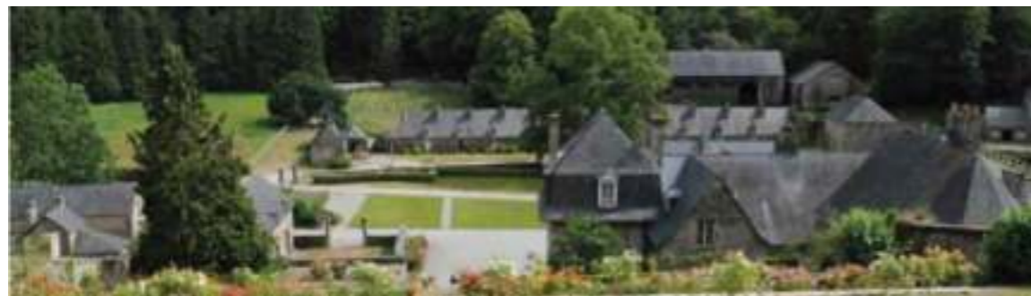
Photographie 40 : Village ouvrier des Forges des Salles implanté dans un contexte encaissé et arboré (source : http://www.lesforgesdesalles.fr )
