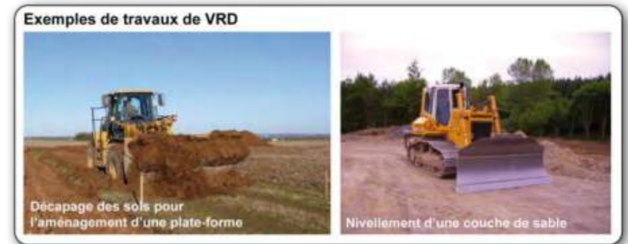
Photographie 54 : Exemples d'engins de travaux de VRD
