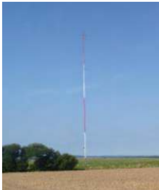
Photographie 2 : Mât de mesure installé sur site (Source : ENCIS Environnement)
